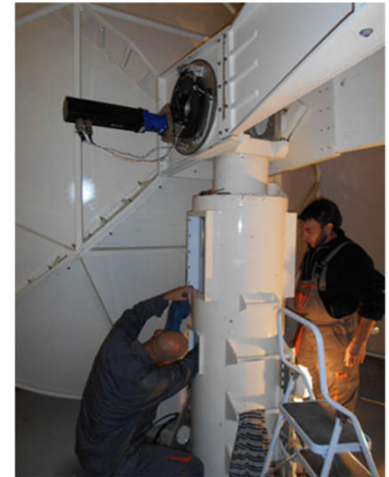
Pedestal szerelés alatt, még a régi függőleges mozgató motorral
